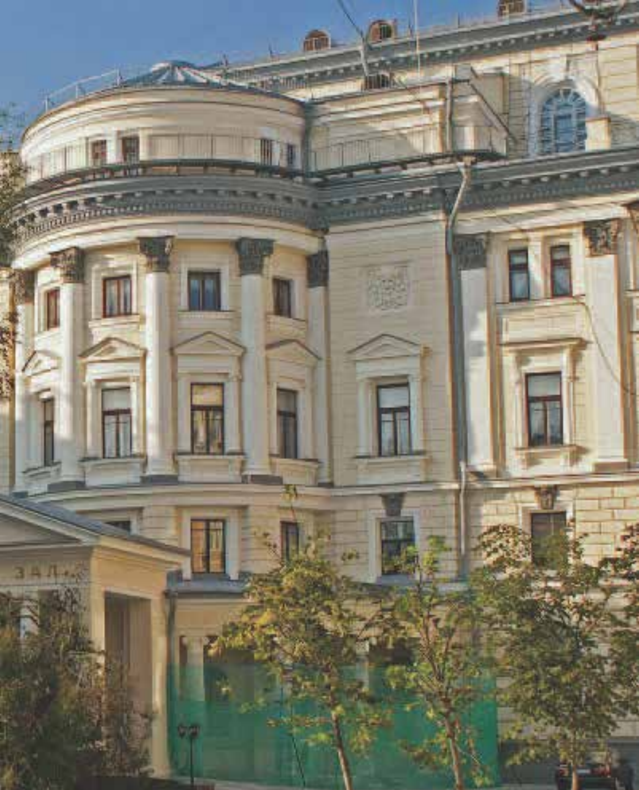
Здание Московской государственной консерватории им. П.И.Чайковского The building of The Moscow State Tchaikovsky Conservatory
