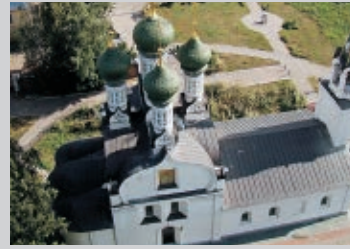
Крыша Успенского храма Roof of the Assumption Church
